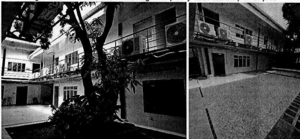
Figura No. 8. Construcción de segundo piso y adecuación primer piso
